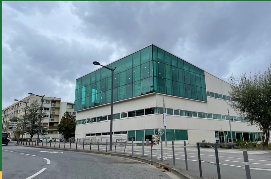
Médiathèque Jules Vernes Vandoeuvre
